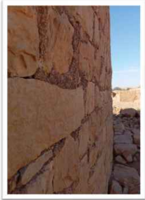
شكل 14: يوضح سمك جدار القصر وطريقة تهيّيب الحجارة من الخارج. المصدر: تصوير الباحث
