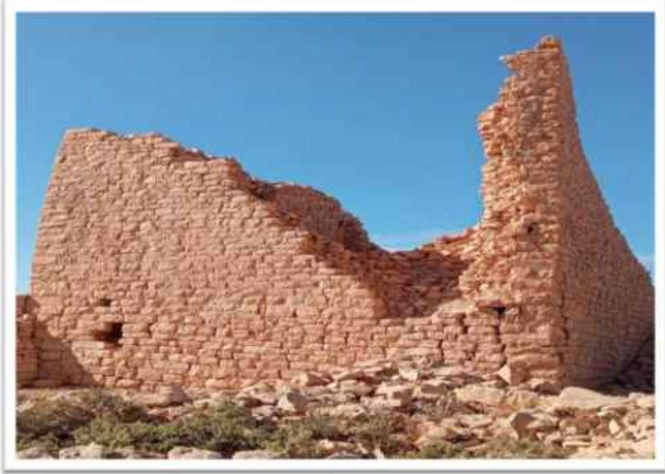
شكل 17: يوضح حالة القصر. المصدر: تصوير الباحث.
