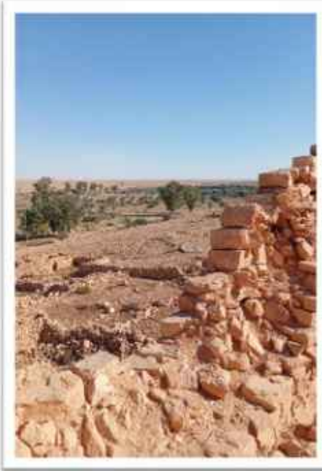
شكل 14: يوضح سمك جدار القصر وطريقة تهيّيب الحجارة من الخارج. المصدر: تصوير الباحث
